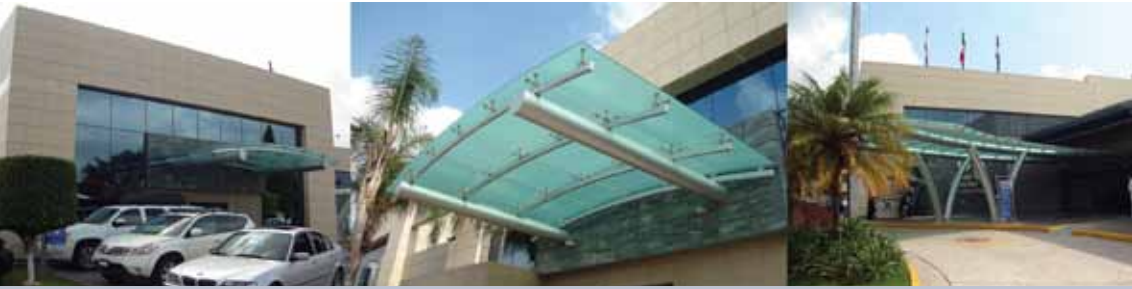
Domos con Arañas Querétaro. Obra: Ventalum. Hospital San Javier, Guadalajara.
