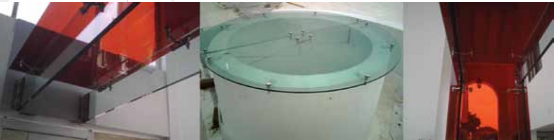
Aplicaciones con Arañas Querétaro. Obra: Cesar Aguilar / ITCA / Cristal templado Cristacurva.
