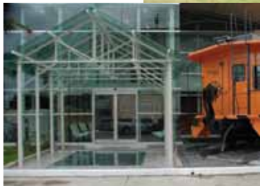
OFICINAS CORPORATIVAS ENLACE FERROVIARIO GUADALAJARA, JALISCO LANROL
