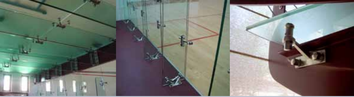
Cancha de squash y gimnasio. Obra MAVISA. Irapuato.
